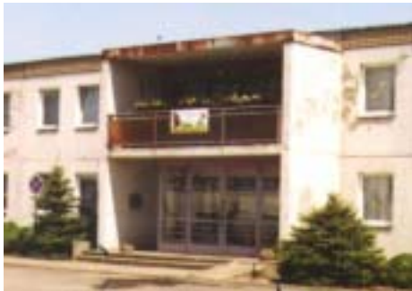
Ansicht vor Sanierung
