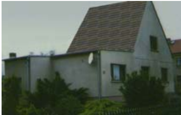
Ansicht Strasse vor Sanierung
