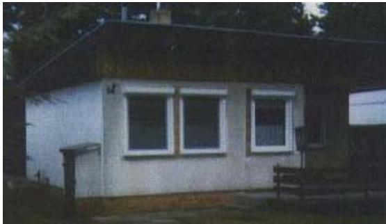
Ansicht vor Sanierung
