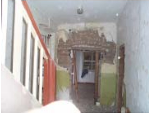
Innenraum vor Sanierung
