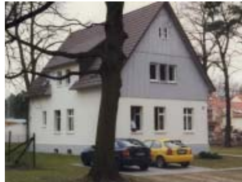
Fassade Strasse nach Sanierung
