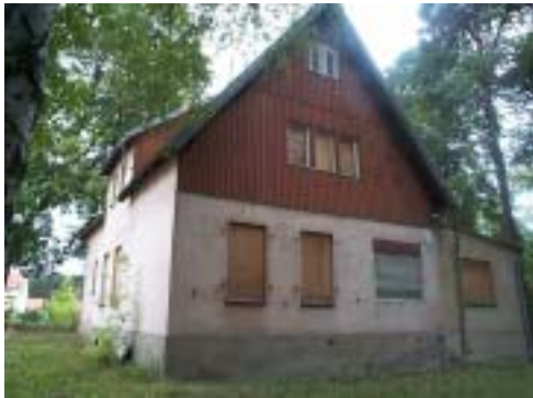
Fassade Strasse vor Sanierung
