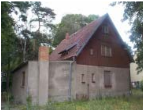
Fassade Garten vor Sanierung
